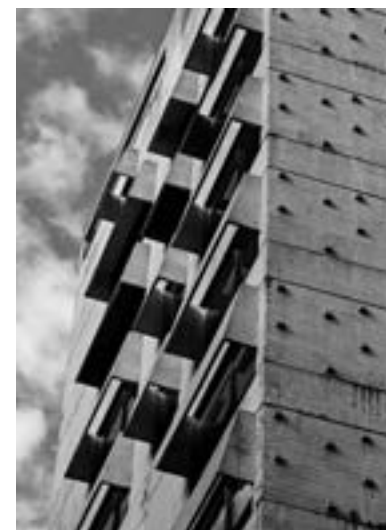
Edificio de la Cancillería y Consulado del Uruguay en la República Argentina. (Arqts. Mario Payssé Reyes, Nayla Laxalde, Carlos Peluffo y Perla Estable, 1977-1978) Buenos Aires.
