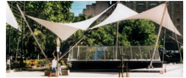
Tensoestructura en el Subte Municipal.
