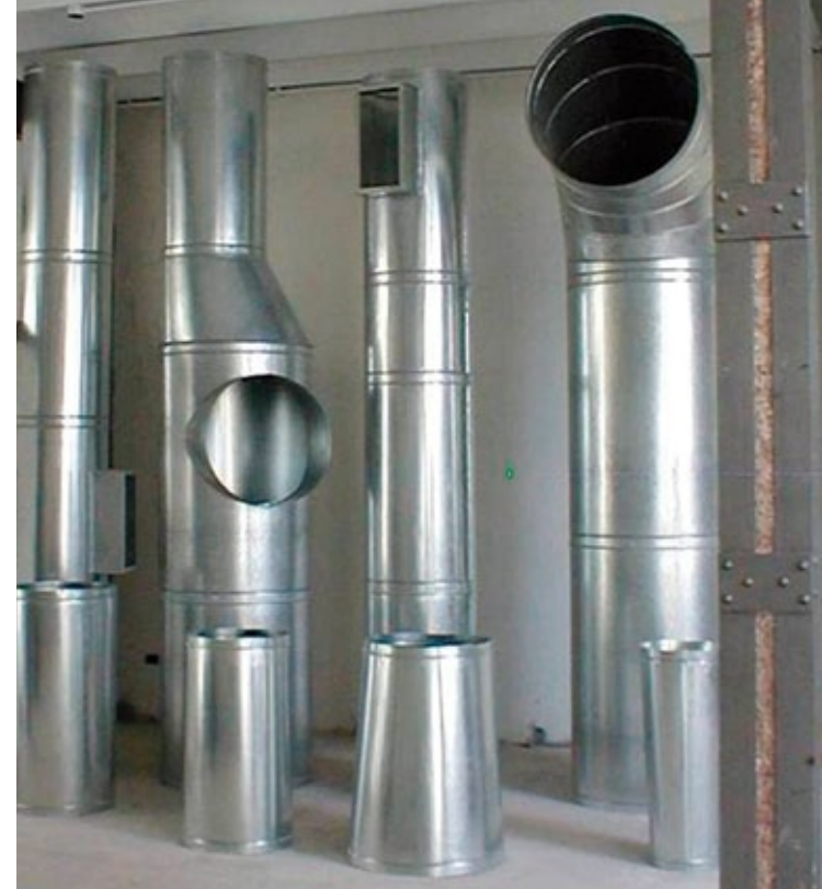
Ductos de aire acondicionado colocados en el Centro Cultural de España. 2000-2003.
